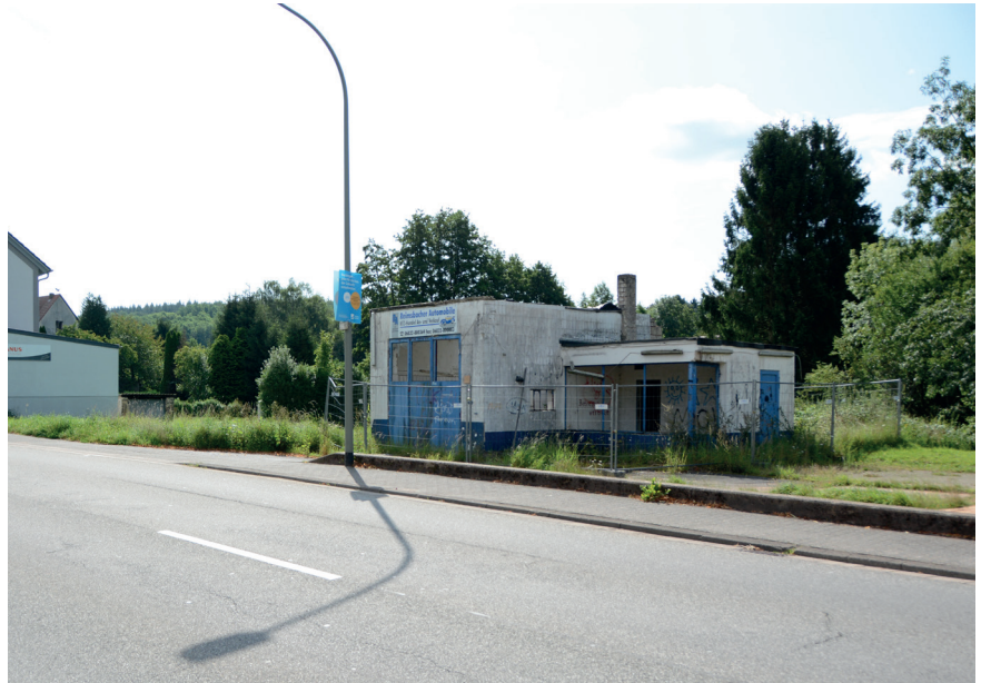
Marodes Gebäude der ehem. Tankstelle
