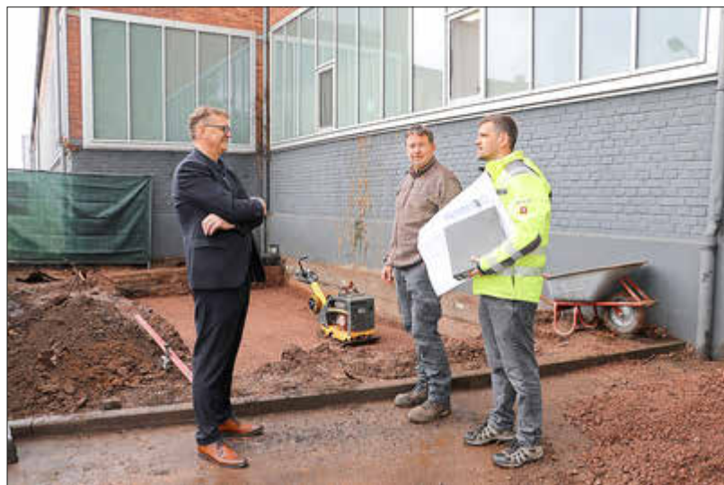
Foto: Bürgermeister Thomas Collmann begutachtete anlässlich des Baubeginns den ausgesuchten Standort vor den Hallen der Firma Nedschroef im Bereich Bahnhofstraße/Ecke Talstraße gemeinsam mit dem Bauunternehmer Carlo Seger und dem Gemeindearchitekt Christoph Hilt.
