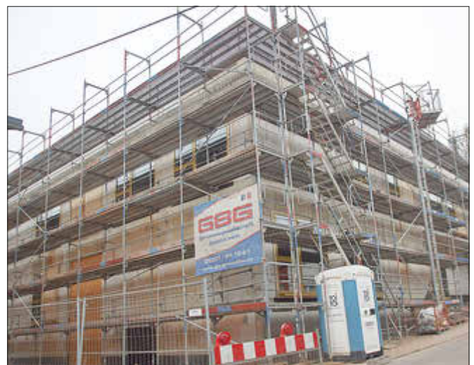
Blick auf den fertigen Rohbau
